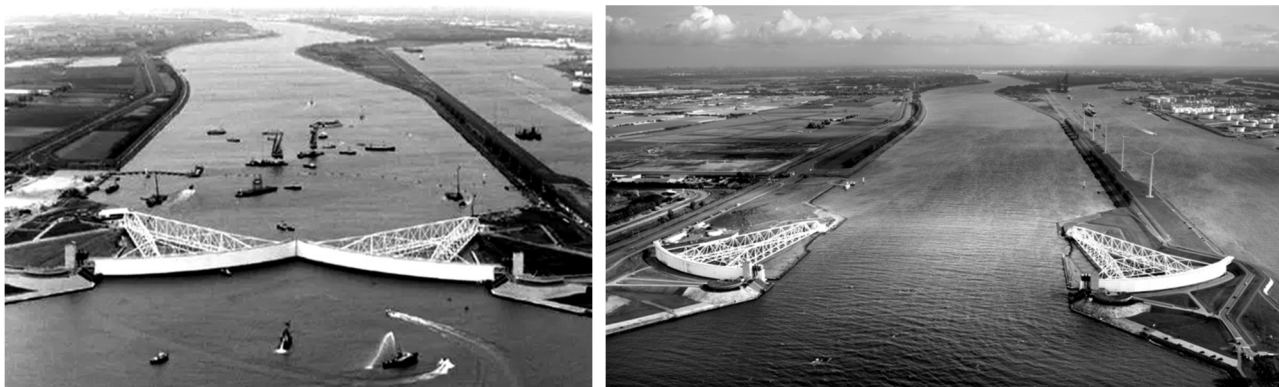
Закрытые (слева) и открытые (справа) затворы Масланткеринга. Фото с сайтов https://kompetiblog2013.wordpress.com/page/41/ и https://www.rijkswaterstaat.nl/english/water-systems/protection-against-water/delta-works/msl-storm-surge-barrier.aspx
