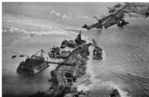
Строительство дамбы Афслютдайк. Фото ноября 1931 г. с сайта http://www.eendijkoaneendijk.nl/Afsluitwebboek/slides/Afsluitdijk%20VieringenFriesland.html
