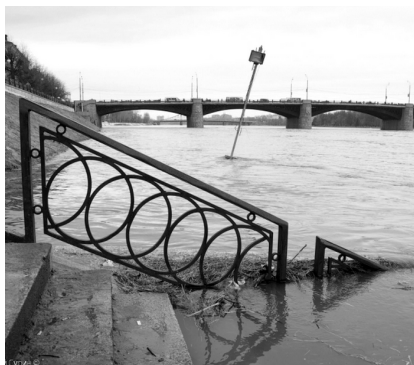
Большая вода в Твери. Апрель 2013. Фото с сайта http://tverigrad.ru/photo/bolshaya-voda-v-tveri
