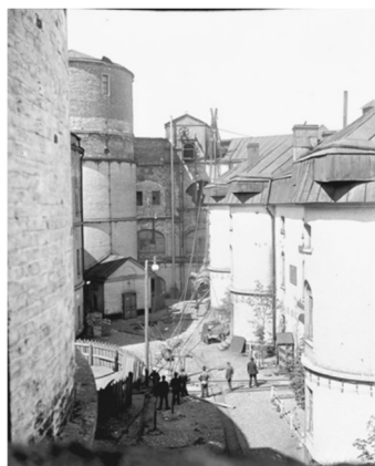
Подъем автоклава для пастеризации вакцин и сывороток на третий ярус форта. Фото конца 1890-х – начала 1900-х гг., автор съемки неизвестен
