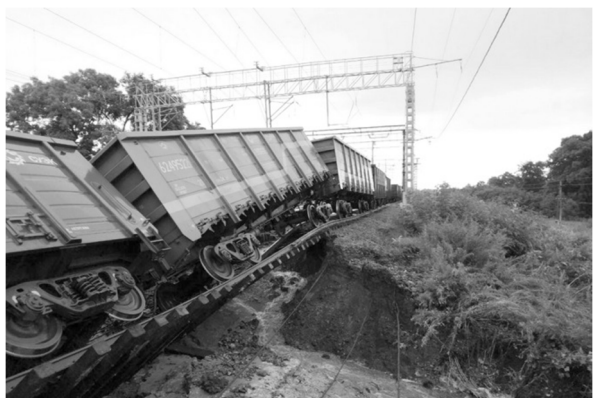
Наводнение 7–11 августа 2017 в Приморье (наверху); на нижнем фото – сошедшие с рельсов вагоны грузового поезда Уссурийск – Боневурово. Фото с сайтов http://primgazeta.ru/news/flooded-primorye-in-the-region-to-restore-the-infrastructure и https://www.newsol.ru/photos/2017/08/07/161676/
