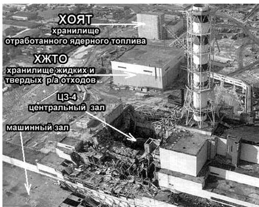
Расположение старого «мокрого» ХОЯТ на промплощадке Чернобыльской АЭС на фоне разрушенного 4-го реактора. Фото с сайта <http://doctoronline.bg/articles/4532/25-godini-sled-Chernobil>
