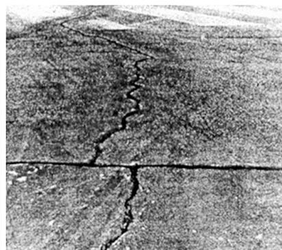
Морозобойные трещины в бетонном покрытии взлётно-посадочной полосы. Фото С.Е. Гречищева, 2001
